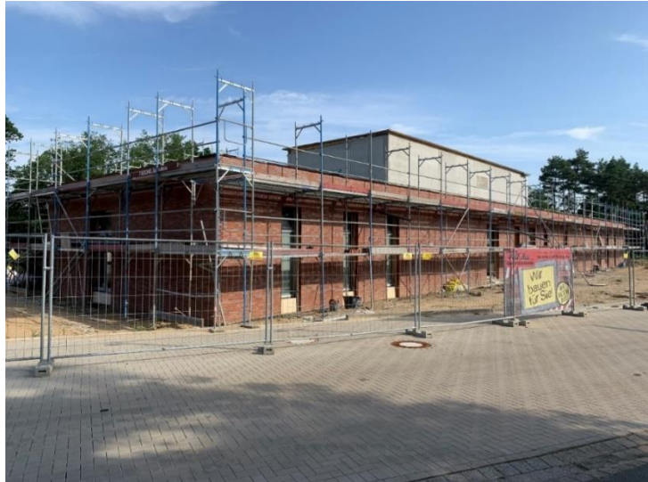
Abbildung 18 – Neubau Wirtschaftsgebäude NLBK Celle/Scheuen
