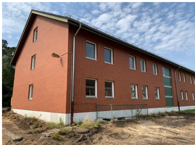
Abbildung 20 – Baubeginn Lehrleitstelle NLBK Celle/Scheuen
